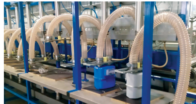
Газовая поверочная установка
