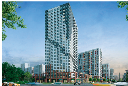
г. Санкт-Петербург, ЖК «Стрижи в Невском 2», к.1 Теплосчетчик – 1591 шт. Счетчик воды – 5279 шт. Электросчетчик – 144 шт.
