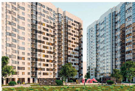
г. Москва, ул. Осташковская, вл. 9/2 Узел коллекторный для отопления – 1091 шт. Теплосчетчик – 551 шт. Счетчик воды – 1420 шт.
