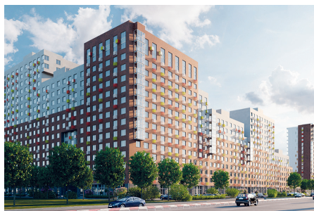
Московская обл., ЖК «Новотомилино», к.1 Узел коллекторный для отопления – 109 шт. Теплосчетчик – 729 шт. Счетчик воды – 1726 шт. Электросчетчик – 11 шт.
