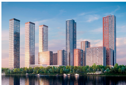
г. Москва, ЖК «Citi Bay», к. 1 Узел коллекторный для отопления – 219 шт. Теплосчетчик – 90 шт. Счетчик воды – 4725 шт.
