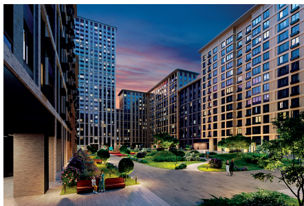
г. Москва, ЖК «Настоящее», к.1 Теплосчетчик – 1847 шт. Счетчик воды – 3204 шт.
