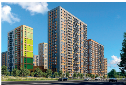
г. Москва, ЖК «КутузовGRAD», к. 5 Узел коллекторный для отопления – 159 шт. Теплосчетчик – 214 шт. Счетчик воды – 918 шт.
