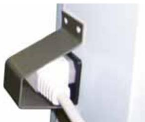
Рис.10 Кабель обогрева периметра двери и защита разъема кабеля.
