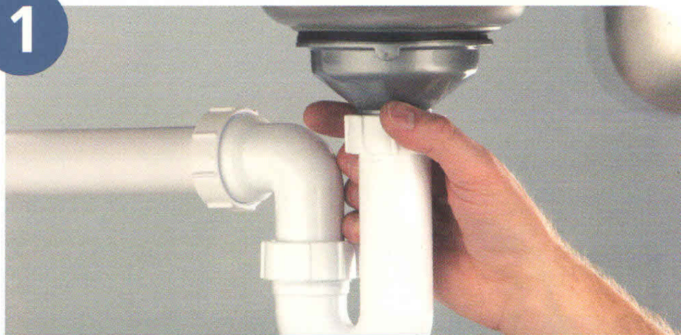
Демонтаж гидрозатвора
