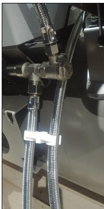
Obr. 12: Umiestnenie prvej dvojitej príchytky
