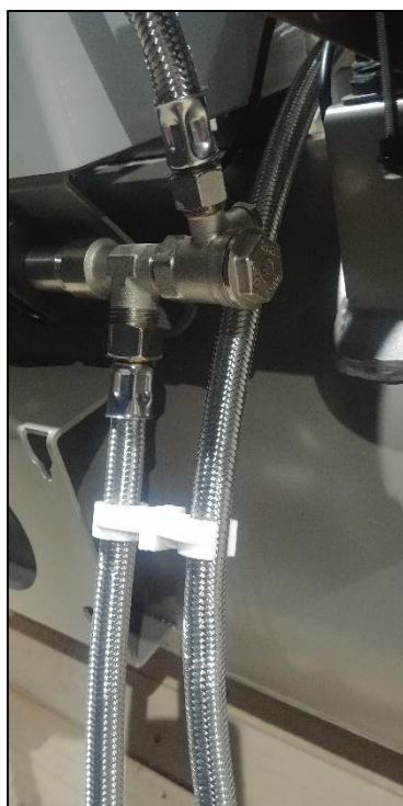
Obr. 12: Umístění první dvojitě příchytky
