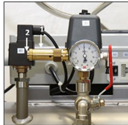
Obr. 22: Kontrola poistného ventilu
