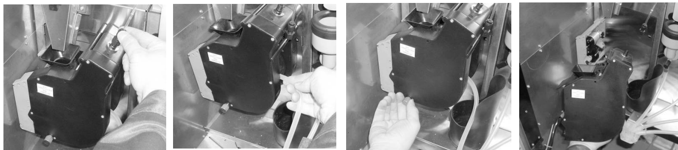
Рисунок 26 — демонтаж группы эспрессо.
