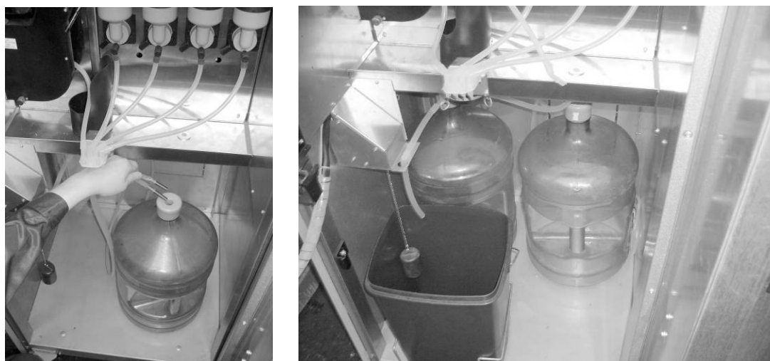
Рисунок 22 — установка автономного комплекта водоснабжения.
