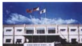
Hitachi Air Conditioning, Филиппины
